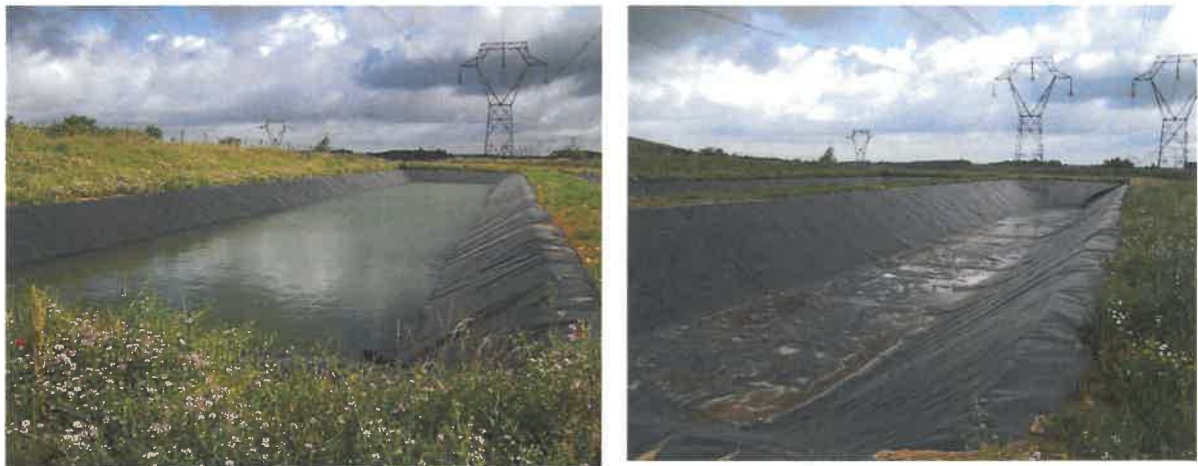
Photo 9 – Bassins de stockage des condensats
